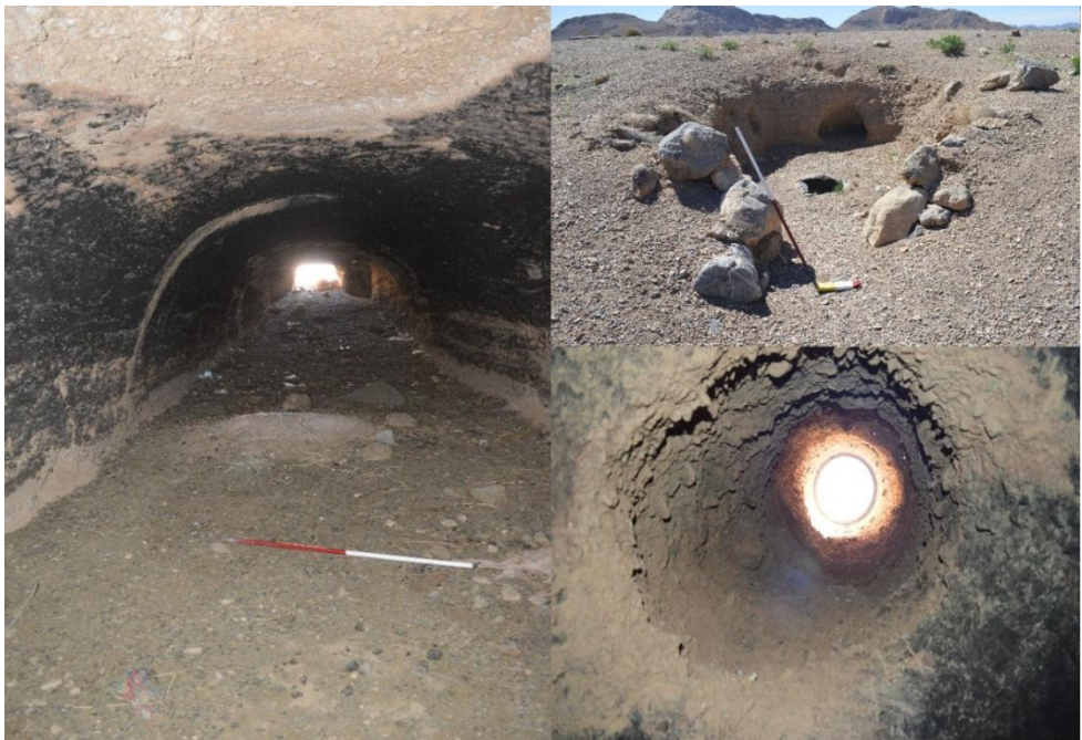
تصویر ۸- قسمت‌های مختلف بکند شامل ورودی، قسمت درونی، هواکش و مردخانه (عکس‌ها از نگارندگان، ۱۳۹۳)
